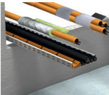
4. Schottmasse so einbringen, dass ein fester, dichter Anschluss zum Bauteil entsteht (Schottdicke mind. 15 cm!). Zwischenräume und Zwickelhohlräume vollständig ausfüllen.
